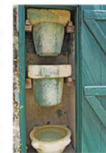
1.24 Este sistema de recolección casera de agua muestra cómo filtrarla para su posterior utilización.
